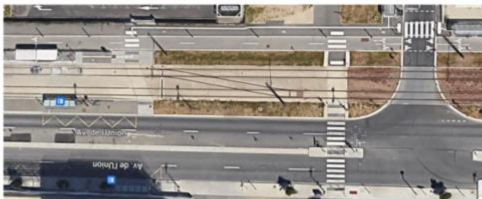
Vue aérienne – Station Cœur d'Orly – Aménagement existant
